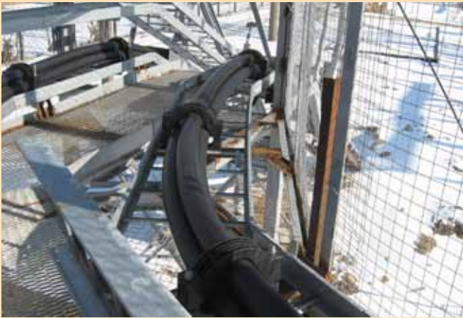
Рис. 2. Первый кабель на напряжение 330 кВ с изоляцией из сшитого полиэтилена, изготовленный заводом «Южкابل» (Украина, г. Харьков)
