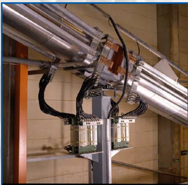
Рис. 3. Система прямого нагрева трубы вулканизации
